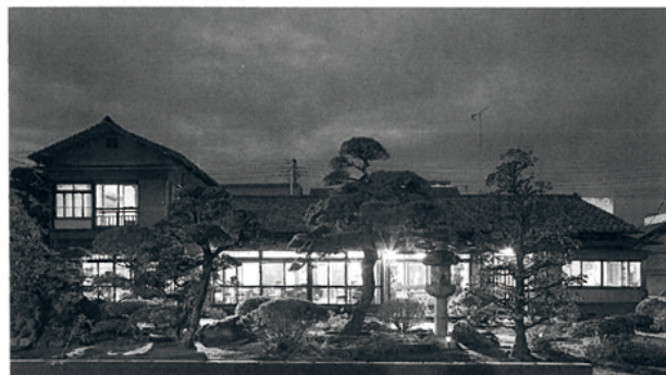
『PLUS+アンカー』建物外観全景
